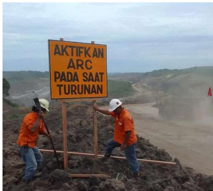
**Gambar 6.** Pemasangan rambu pada turunan Cp757
