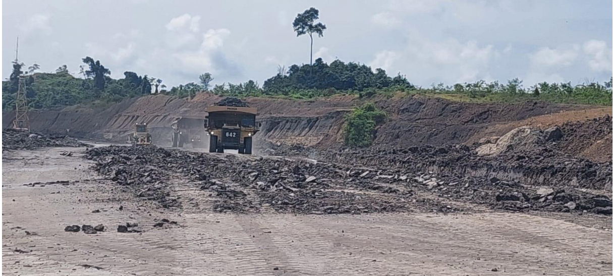
Gambar 10. Kondisi jalan scorpio segmen 6 Pit Pinang South tanggal 26 Juni 2023 saat dilakukan perbaikan oleh grader
