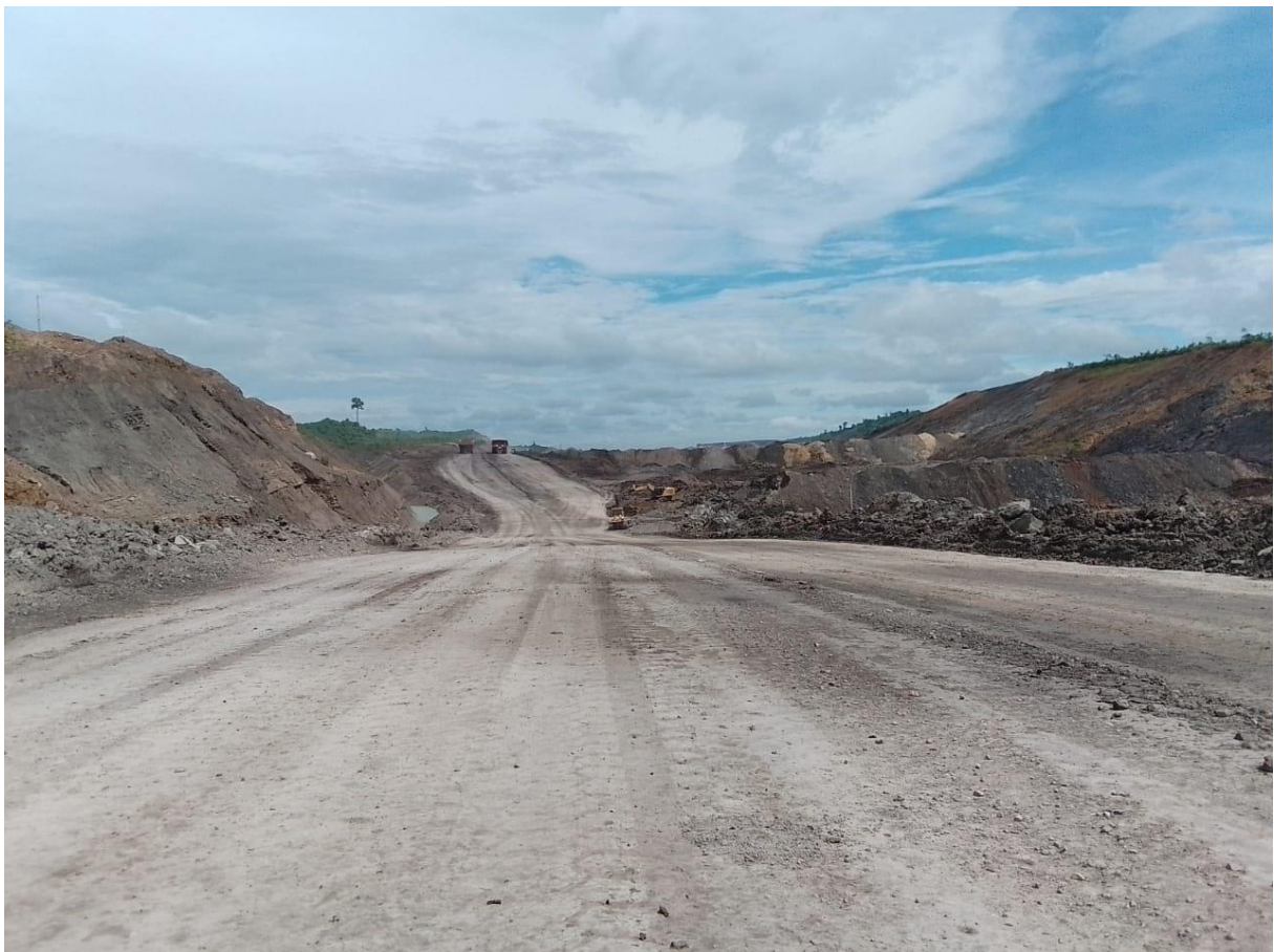
Gambar 11. Kondisi jalan scorpio segmen 6 tanggal 26 Juni 2023 setelah dilakukan perbaikan
